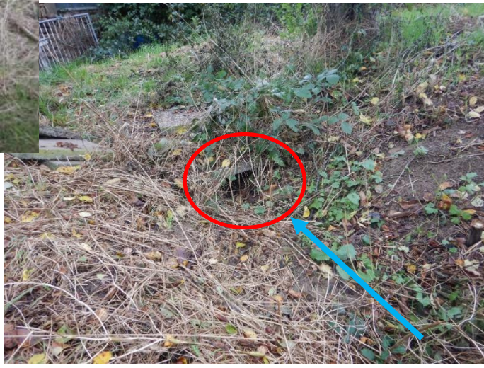
Einlauf vor dem Gebäude
