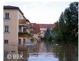
Hochwasser in der Stadt
