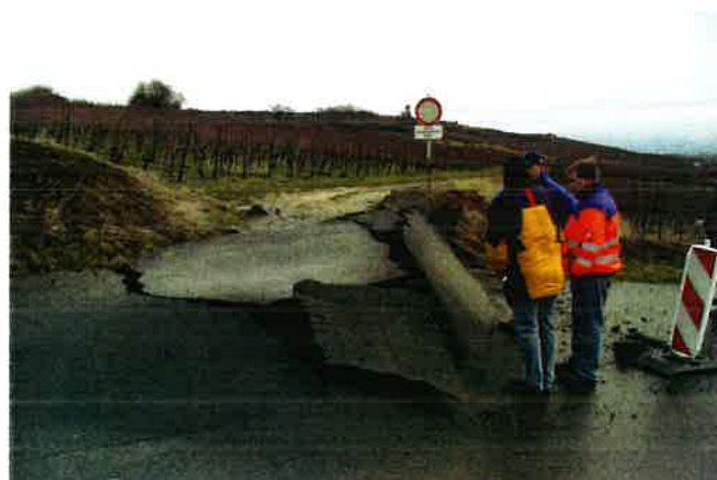
Rutschung an der K 66 zwischen Zell und Niefernheim. (Foto: LGB/ Ch. Pappert)
