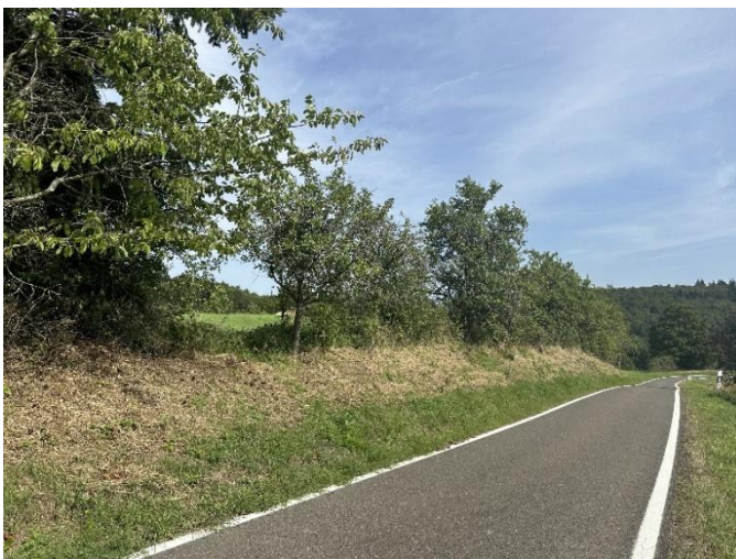
Abb.10: Ansicht MD2 mit Böschung
